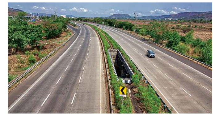
2014 से देश में 3.75 लाख किमी लंबी नई सड़कों और हाईवे का किया गया निर्माण। फाइल
